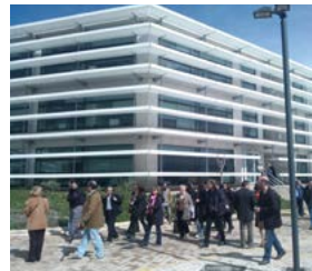
Edificio OTE/Cosmote Paiania (GR)
