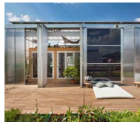
Vivienda solar LOW3 y 57 Residencias universitarias, campus ETSAV-UPC Sant Cugat del Valles, Barcelona (ES)
